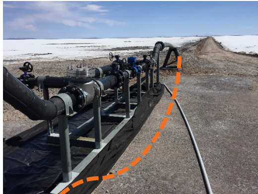
Pozos de Bombeo
