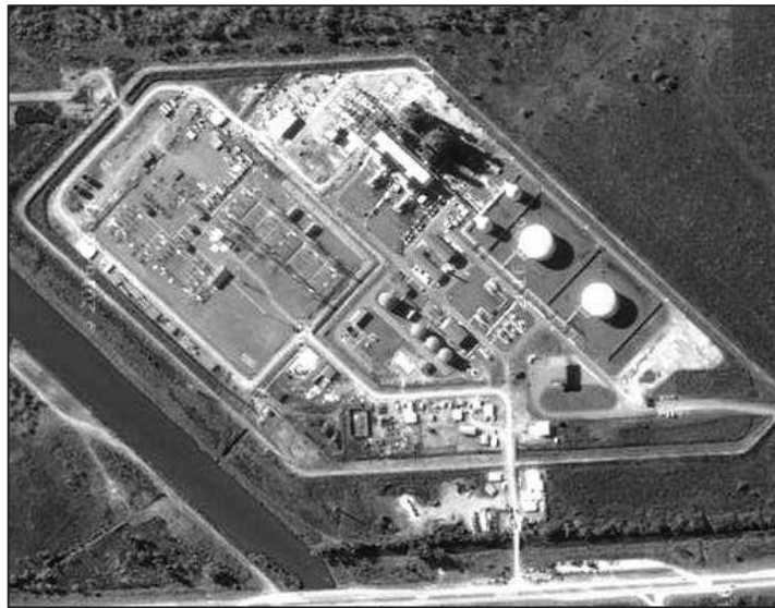
Figura 1. Central Termoeléctrica Ensenada Barragán.
